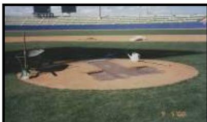
Décaissage du monticule sur l'épaisseur des briques
